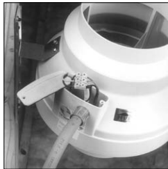
Câblage serré de liquide - vue de dessus (pour des installations extérieur)
