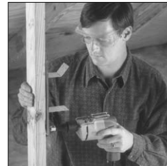
Fixer le support de montage (MB).
