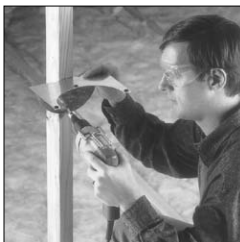
Fixer le support de montage (NB)
